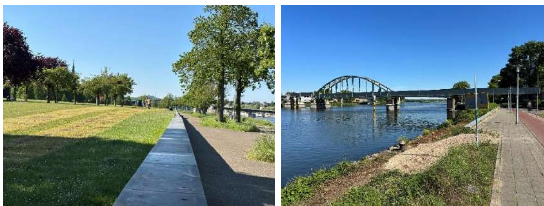
Figuur 2.29: Links het Griendpark, waar het contact met het water (ondanks het mooie uitzicht) ontbreekt en het park qua verblijfsplek niet optimaal is ingericht, de verbindingen naar en vanuit het Griendpark zijn onvoldoende: het fietspad is in één richting en de route loopt niet door langs het water.
