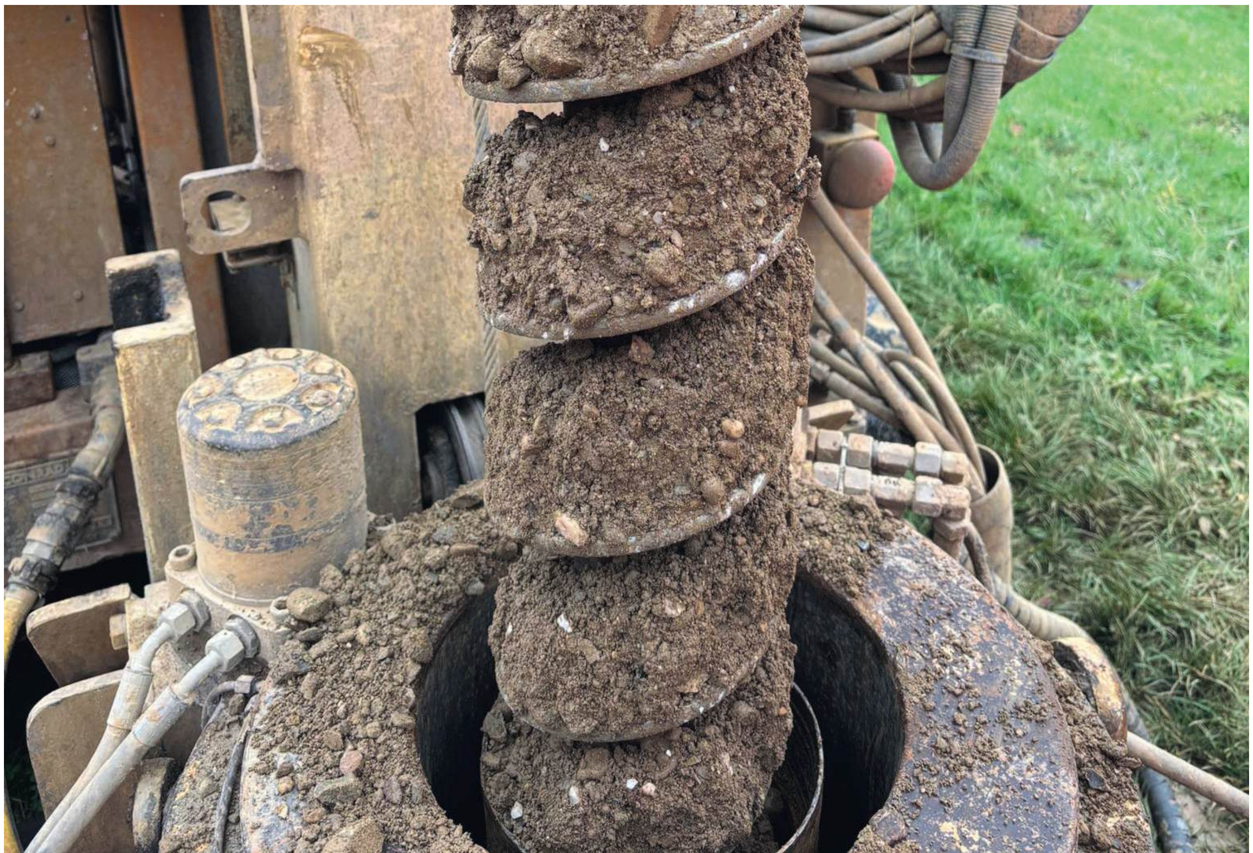
Machinale boringen in Itteren
